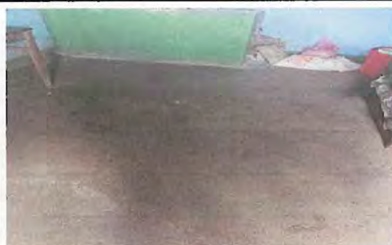
Foto 4: Sustrucción de piso de torta por piso antideslizante (cocina)
