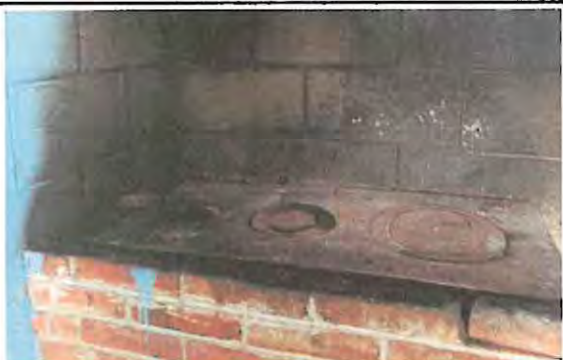
Foto 3: Sustrucción de estufa rural
