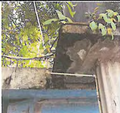
Foto7: Sustitución de tubería pvc de agua potable y drenaje
