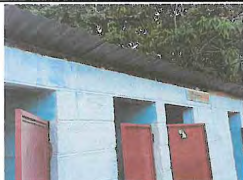
Foto 9: Sustitución de lámina acanalada por lámina troquelada (cocina y sanitarios)
