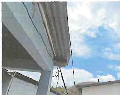
Foto 1: Sustrucción de Sistema Eléctrico fuerza e iluminación (aulas sanitarios, bodegas y cocina)
