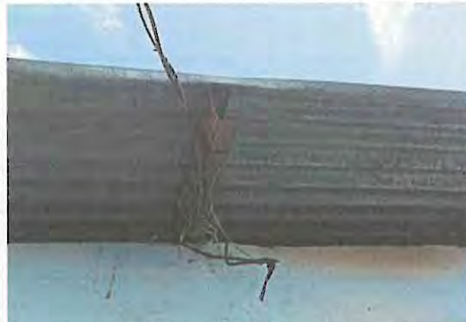
Foto 2: Sustrucción de Sistema Eléctrico fuerza e iluminación (aulas sanitarios, bodegas y cocina)
