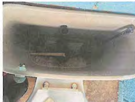
Foto 8: Sustitución de accesorios para sanitarios
